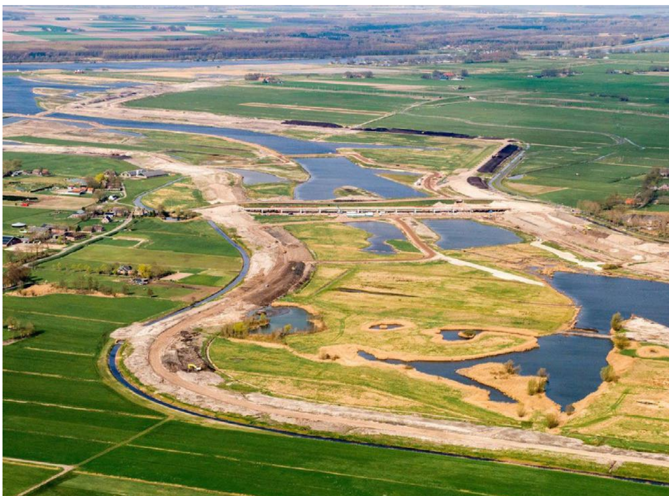
Het Reevediep en de klimaatdijk in aanleg
