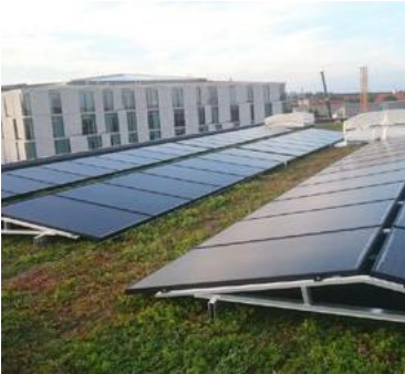
Zo wel: PV-panelen onder een hoek richting de zon op platte (groene) daken
